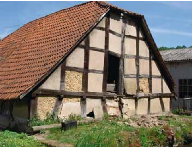
Oberer Eisenhammer vor der Restaurierung Foto: Horst Vöge
