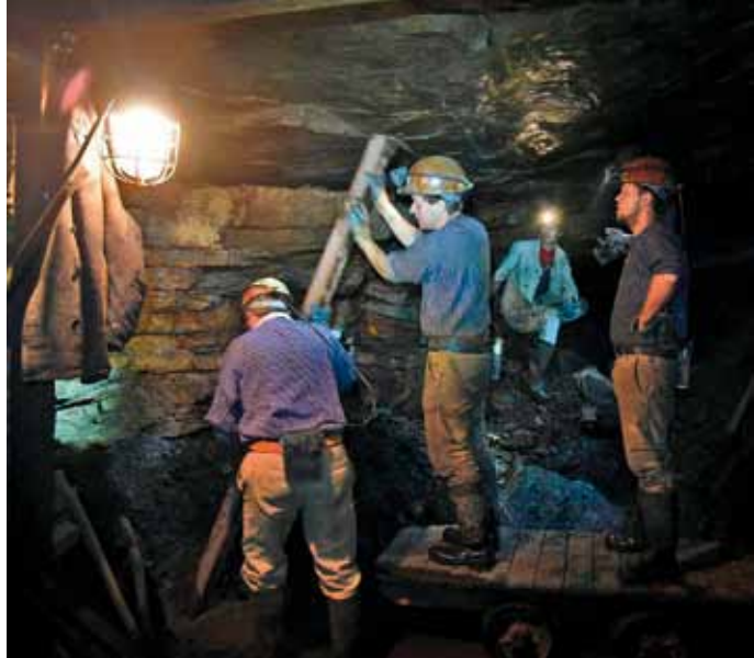
Aufwältigungsarbeiten in der Grundstrecke Bild: Sammlung Feggendorfer Stolln
